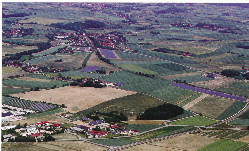
Insbesondere entlang der Bahnlinien sind Freiflächen-Photovoltaikanlagen entstanden, wie hier bei Unterdeggenbach
